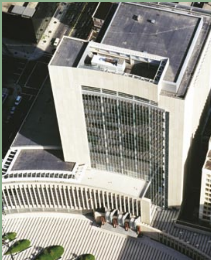
El edificio del tribunal federal en Minneapolis, Minnesota cuenta con un EPDM totalmente adherido.
