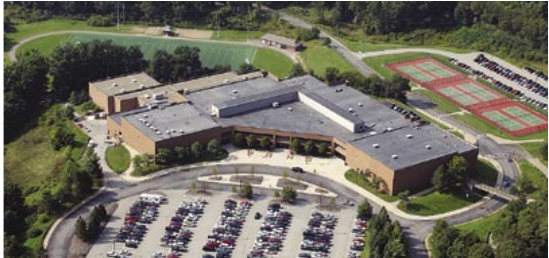
Système de recouvrement EPDM entièrement collé sur la Shaler High School, Pittsburgh, Pennsylvanie, comportant une membrane de 60 mils fournissant la durabilité et la longévité exigées par le cahier des charges du système.
