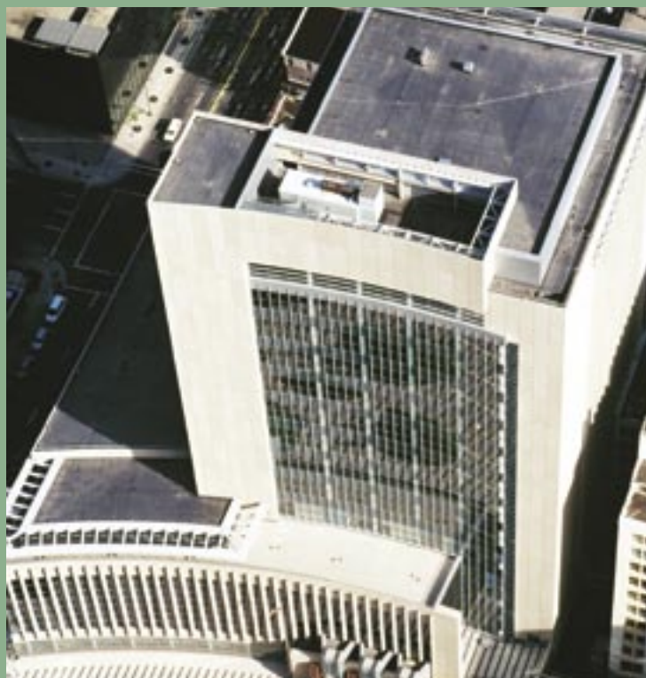
Le bâtiment du palais de justice fédéral américain de Minneapolis comporte une membrane EPDM entièrement collée.
